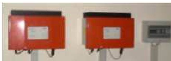
Wechselrichter - Datenlogger
