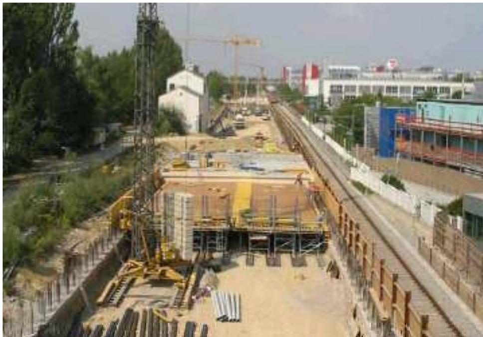
**Abbildung 7: Bsp. Herstellung eines Rechteckquerschnittes in Deckelbauweise**
