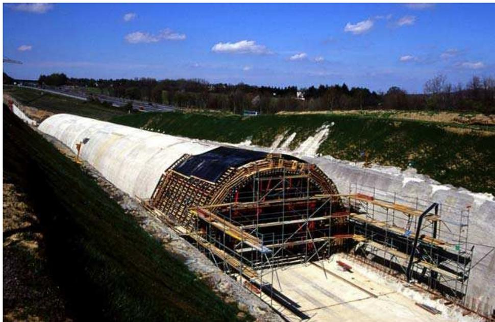
Abbildung 1: Bsp. Herstellung eines Gewölbequerschnittes in offener Bauweise
